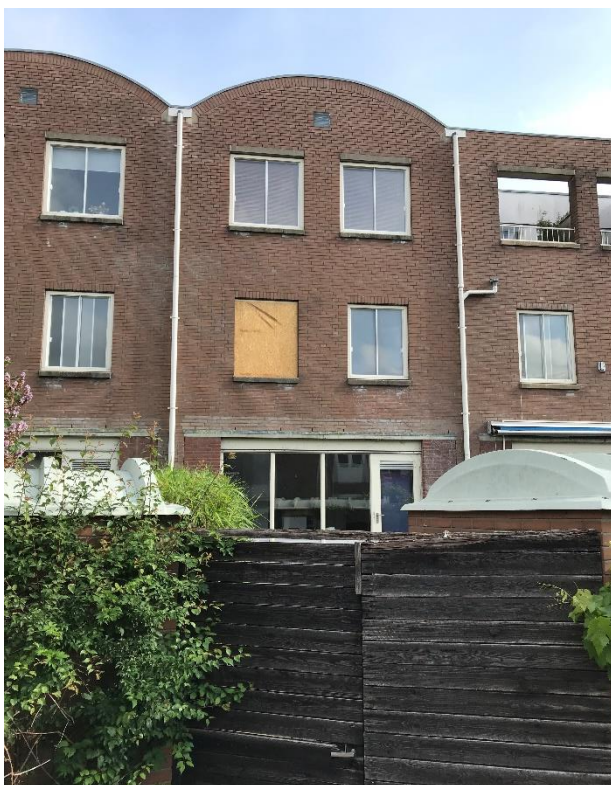
Foto 2: foto achterzijde Pastoor Jansenstraat 11
